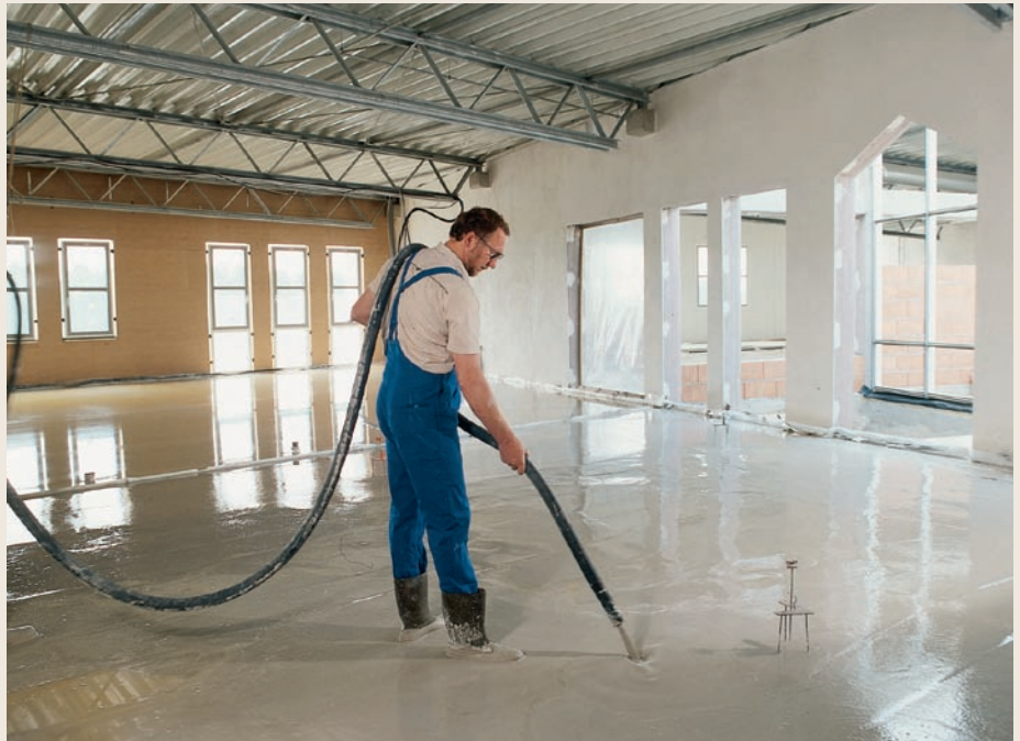
Der Fließestrichmörtel wird in gießfähiger Konsistenz in der Regel maschinell in das Bauwerk eingebracht. Ein Pumpen des Mörtels über längere Distanzen und größere Höhen stellt dabei kein Problem dar.
