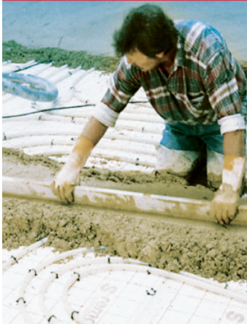
Konventioneller Calciumsulfatestrich als Heizestrich, eingebracht im Lindnerhotel BayArena, Leverkusen
